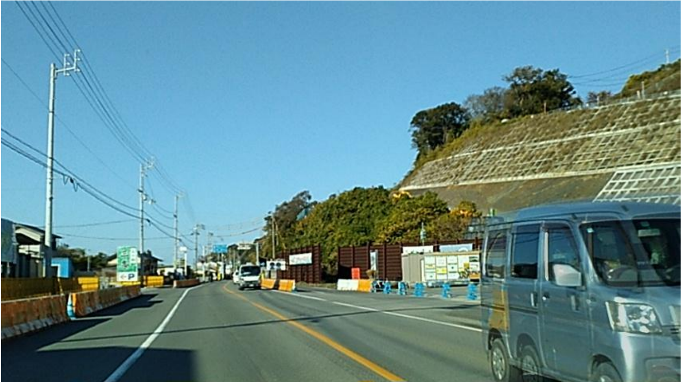
安芸西インターチェンジ（仮）入口（このインターチェンジからは室戸方面へ行けません）
