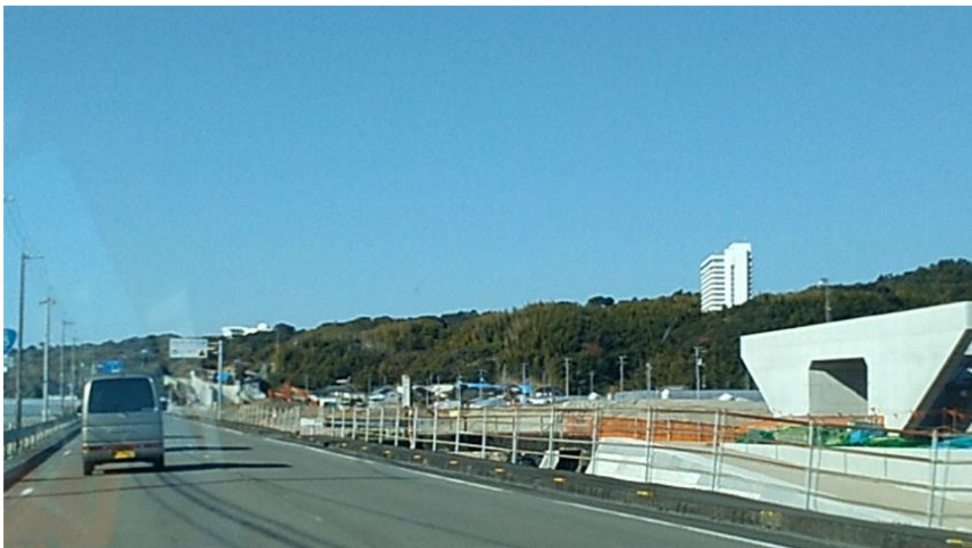
芸西西インターチェンジ付近
