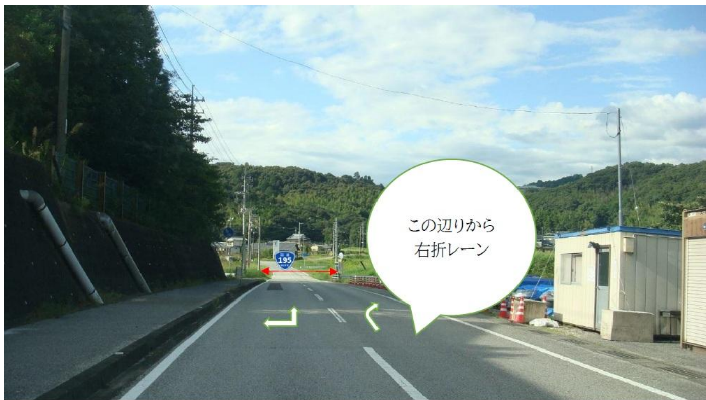
山田バイパス完成後の状況(高知県の資料に基づいて加筆)
